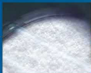
Обмерзание теплообменника
